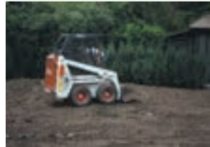
Nach dem ebenen Ausplanieren, wird der Boden mit der Fräse gelockert.
