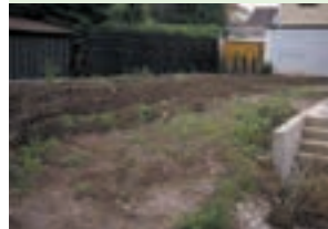
Anfangs ist die Fläche uneben und Wurzeln und Steine sind zu entfernen.
