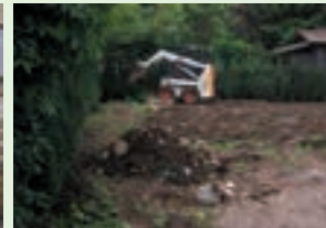
Anfangs ist die Fläche uneben und Wurzeln und Steine sind zu entfernen.
